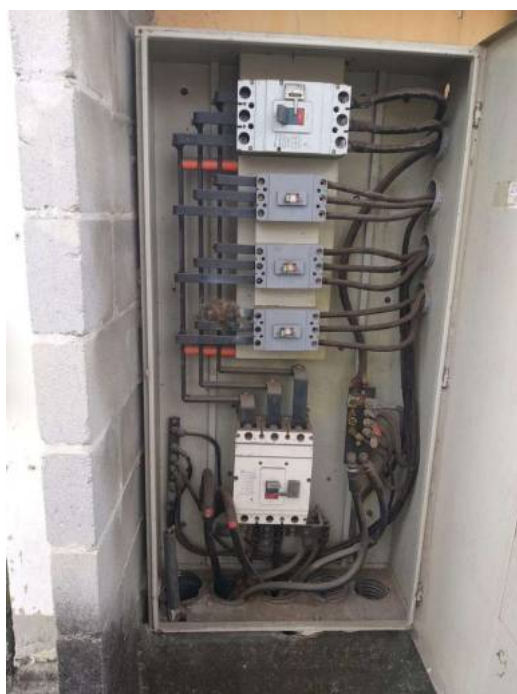
Figura 3-QGBT com 5 disjuntores.
