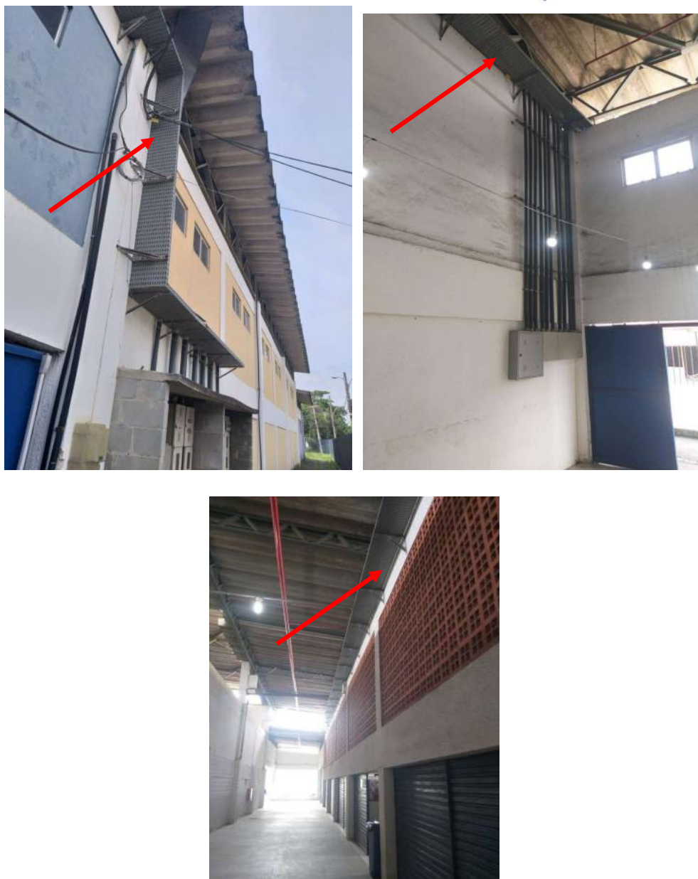
Figura 5-Eletrocalha percorre o galpão.
